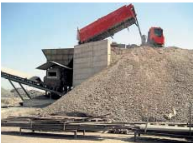
»1 Delivery of the marl clay by lorry and emptying into box feeders »1 Anfuhr des Mergeltons mit Lkw und Entleerung in Kastenbesicker
