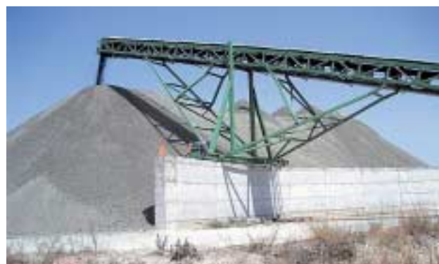
»2 Slewling belt to deposit the marl clay on a storage pile »2 Schwenkband zum Aufschütten der Mergelton-Vorratshalde
