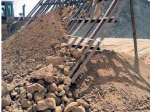
»3 Simple but efficient method of separating coarse clods »3 Einfache, aber effiziente Methode zum Aussondern von groben Schollen
