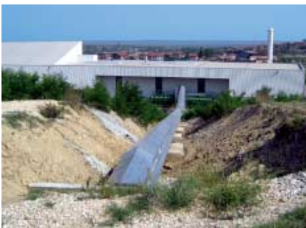
»4 Conveyor line with rain cover, from pit to factory – in the background on the right the preparation plant and on the left hand side the souring shed with its lean-to roof »4 Bandstraße mit Regenabdeckung, von der Grube zum Werk – im Hintergrund rechts die Aufbereitungshalle und links, mit Pultdach, das Sumpfhaus
